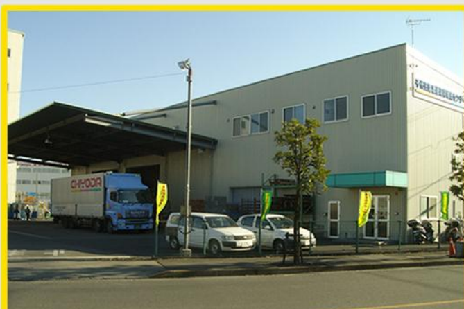
CLC羽村 新物流センター
